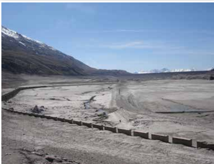
La strada Statale n. 25 annegata nella diga attuale.
